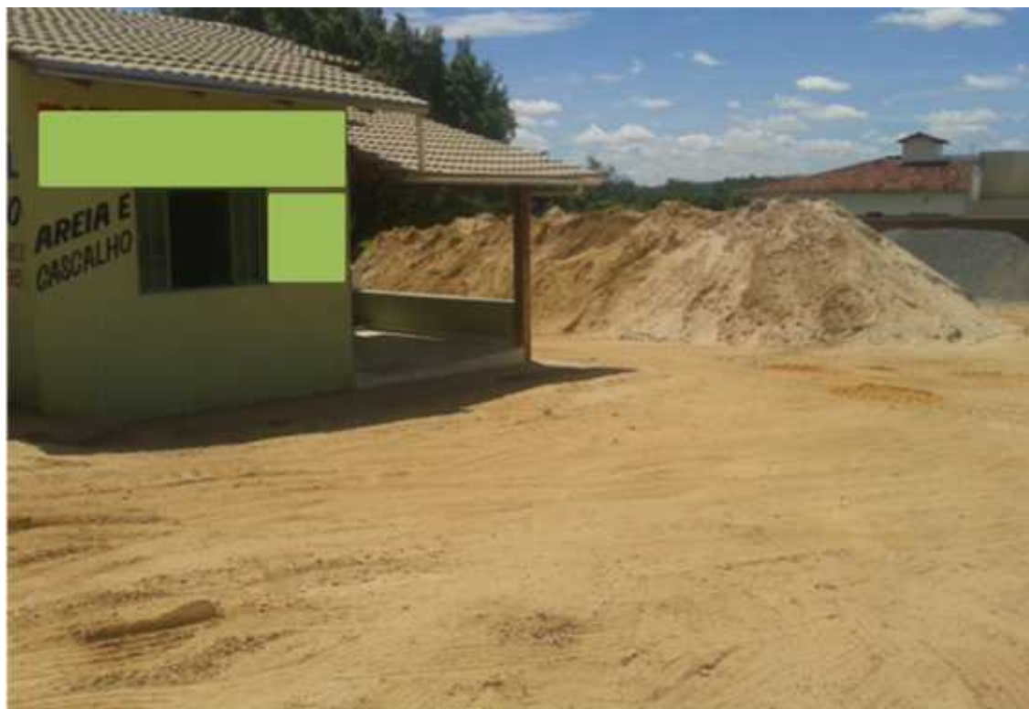
FIGURA 1 – Vista Frontal da empresa
